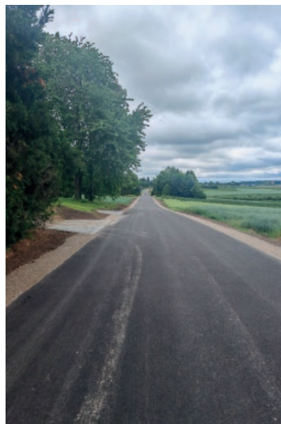
Droga gminna nr 107730L w Klementowicach
