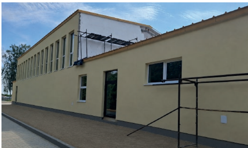
Postęp budowy sali gimnastycznej w Klementowicach
